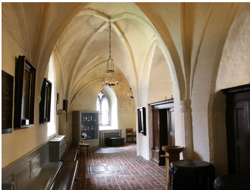
Norra koromgången med tidstypiska valv som daterar den östra delen av den nuvarande kyrkan till mitten av 1300-talet.
